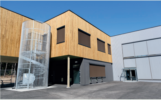
Det er royalimpregnert trekledning, sinusplater og cembrittplater på fasadene.
